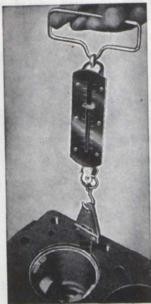
Bild 31. Mätning av kolvspel
