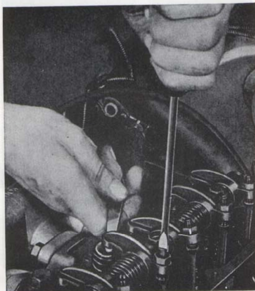
Bild 28. Justering av ventilspelet
