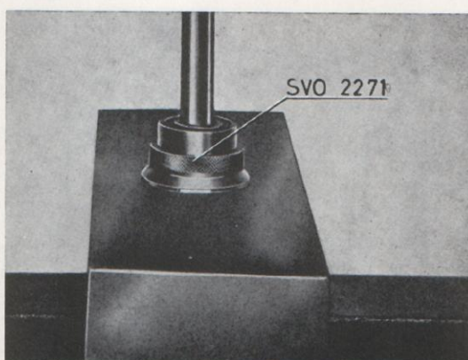
Bild 76. Montering av kullager.
