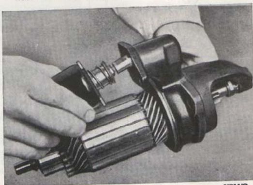
Bild 41. Losstagning av manövermagnet.
